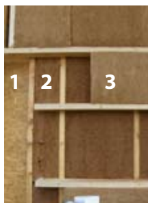
Sur cette photo, on aperçoit : la plaque d'OSB intérieur (1) la 1 ère couche de laine de bois (2) la 2 ème couche de laine de bois (3)
