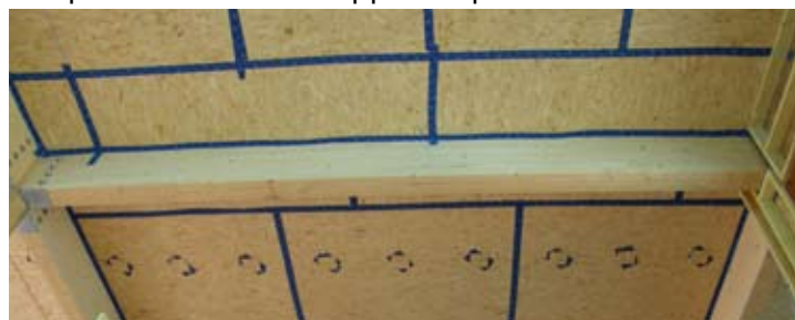
Détail du plafond, le scotch d'étanchéité joint chaque plaque d'OSB entre elles
