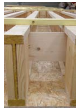
Détail d'une poutre en I
