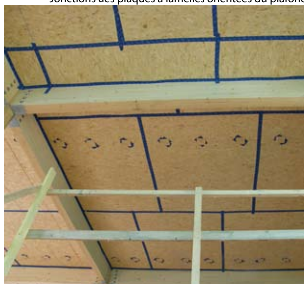
Jonctions des plaques à lamelles orientées du plafond
