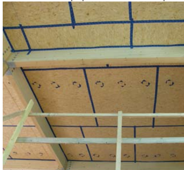
Jonctions des plaques à lamelles orientées du plafond
