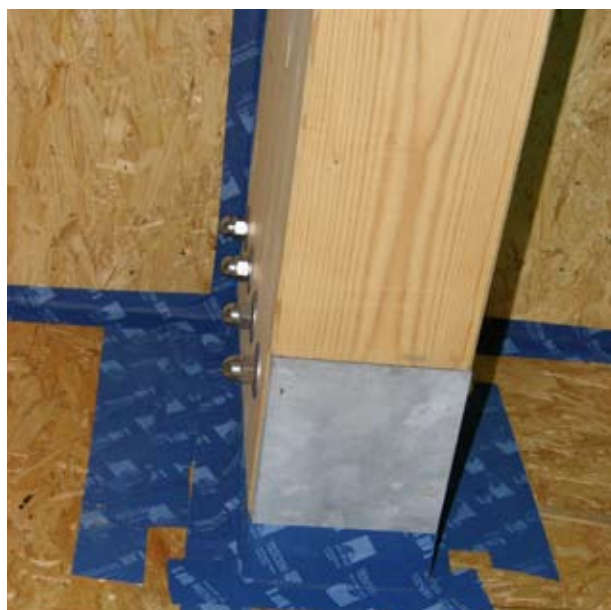
Jonction entre une poutre, le mur et le plafond
